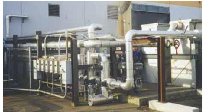
*An example of oversized insulation and aluminum fittings. / Isolation surdimensionnée et raccords d'aluminium.*
