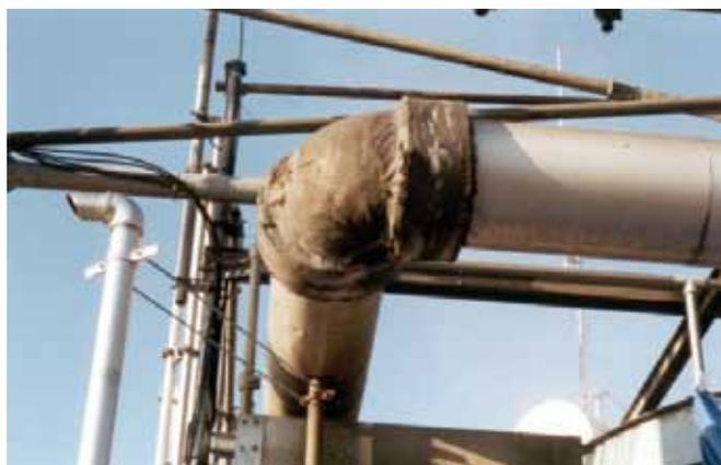
A typical example of glass fibre mesh and mastic elbow. / Coude avec toile de fibre de verre et mastic.
