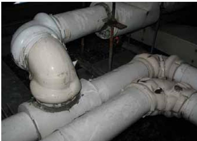
An example of PVC fittings used in an outdoor environment, notice discoloration and significant damage. / Raccords en PCV employés à l'extérieur – on voit qu'ils sont décolorés et considérablement endommagés.
