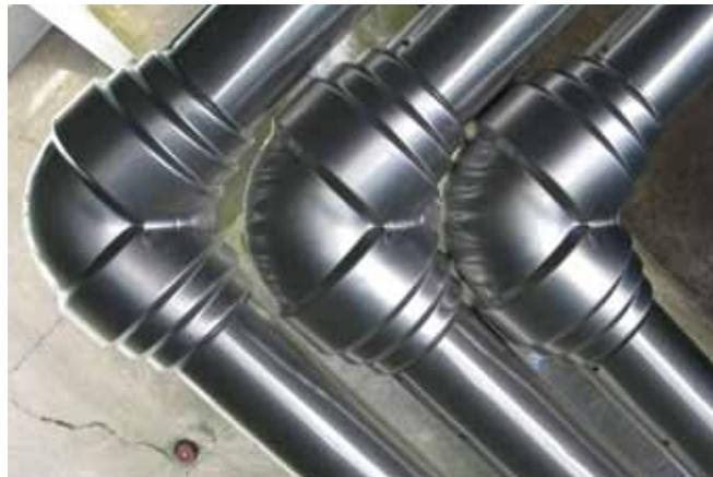
*Pressed aluminum fittings designed for use on Victaulic piping. / Raccords d'aluminium pressé conçus pour les produits Victaulic.*
